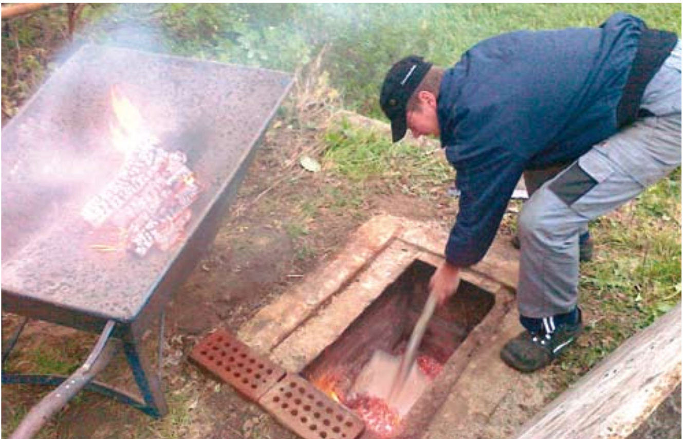
Kuuma hiillos poistetaan kuopasta.
