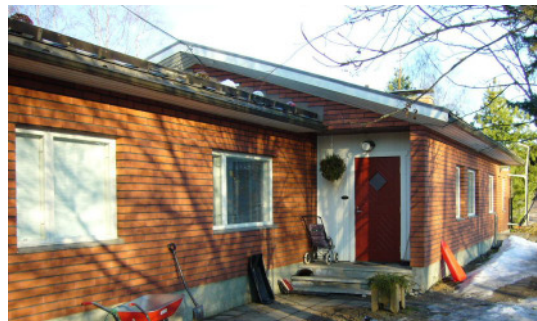
Kuvassa lastensuojeluyksikkö Veitikan Koivulan rakennus. Siellä asuvat pienimmät asukkaat.
